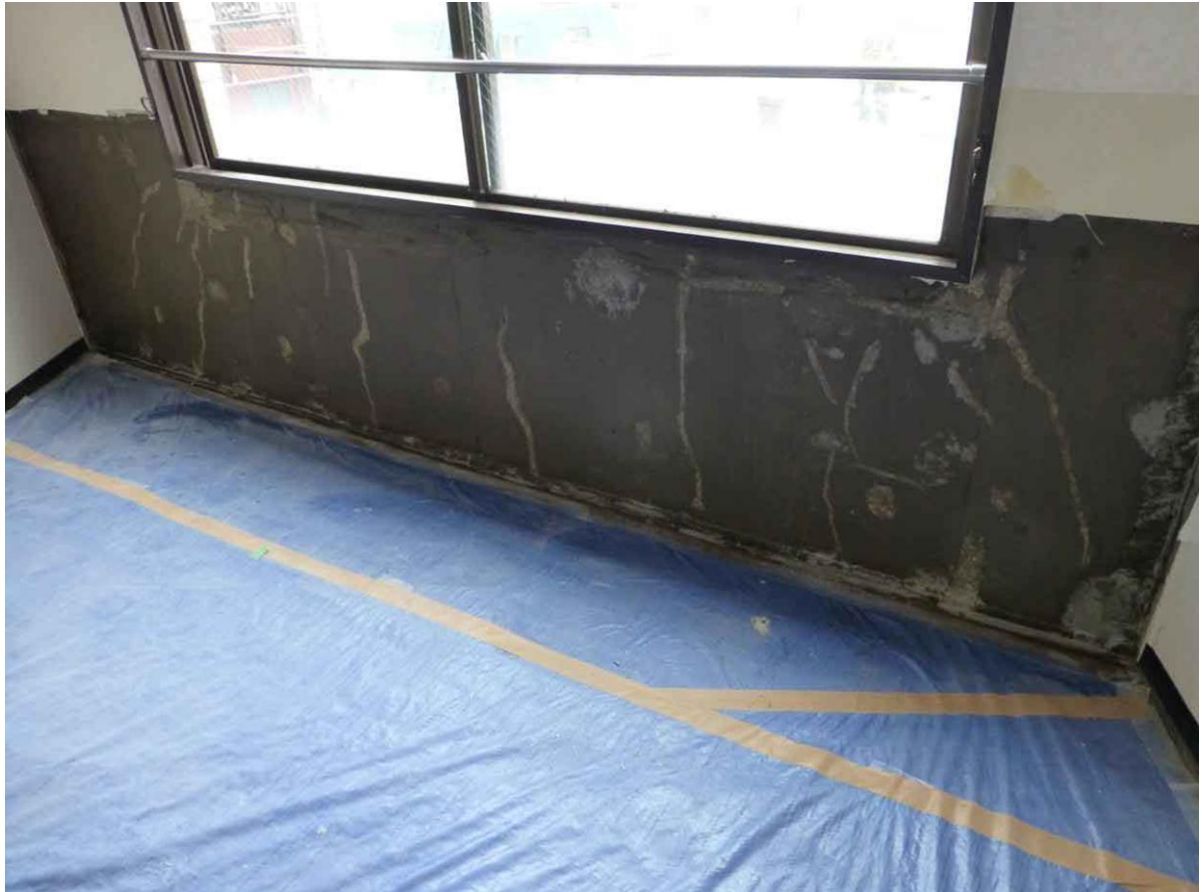
完了（白い跡がひび割れの処理を実施した箇所）
